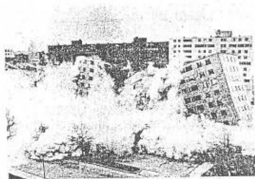
3. MINORU YAMASAKI, Viviendas Pruitt-Iggo, St. Louis, 1952-1955. Varios bloques laminares de este proyecto fueron dinamitados en 1972 después de haber sido continuo objeto del vandalismo. El porcentaje de crimen era mayor que en otras urbanizaciones, y Oscar Newman atribuyó esto, en su libro Defensible Space , a largos y anónimos pasillos y a la falta de espacios semiprivados controlados. Otro factor es que se diseñó en un lenguaje purista que no concordaba con los códigos arquitectónicos de los habitantes.
